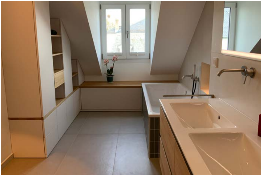
Hinter der breiten Vorwand verschwinden die Rohre, und der Einbauspiegelschrank wird integriert. Der Einbauschränk (links) verfügt über offene und geschlossene Bereiche.
